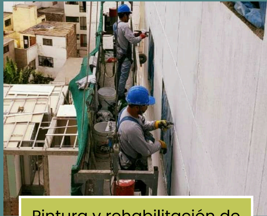
Pintura y rehabilitación de fachadas residenciales y comerciales.
