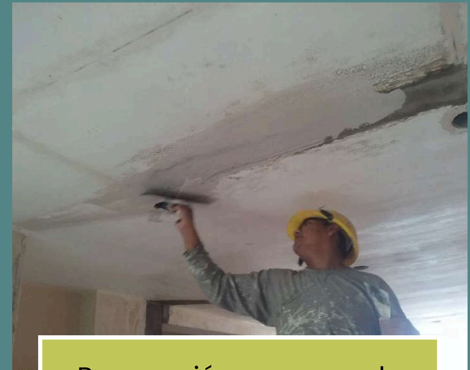
Reparación y resane de muros, techos y cielos rasos
